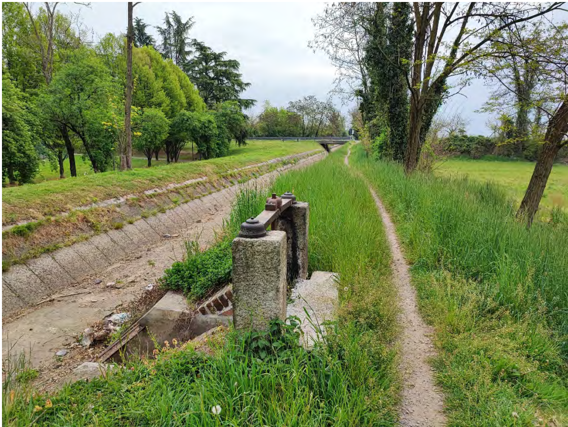
Foto n° 15 ( Vista canale Villoresi e Ciclabile - N/E )
