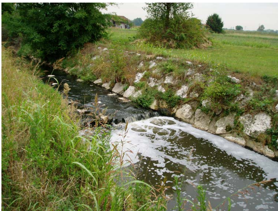
Foto 13 – Tratto del T. Trobbia interessato da lavori di sistemazione spondale e in alveo.
